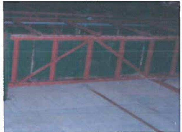
Рисунок 2.101 – Корозія металевих балок та
