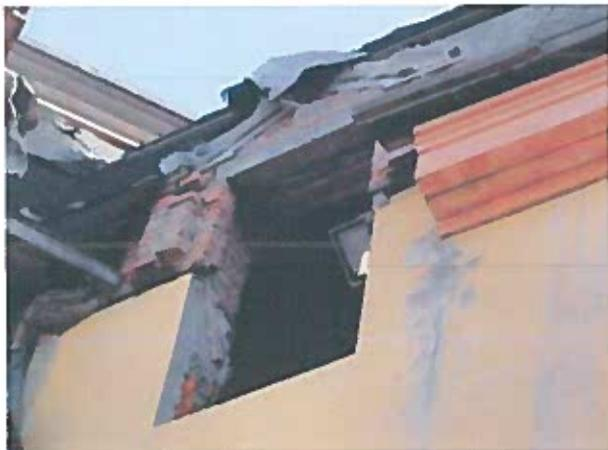
Рисунок 2.85 – Розмерзання, вивітрювання цегляної кладки зовнішньої стіни
