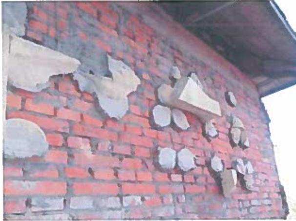
Рисунок 2.77 - Розмерзання, вивітрювання цегляної кладки зовнішньої стіни, відсутність утеплювача
