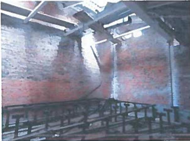
Рисунок 2.63 – Неякісне заповнення швів цегляної кладки
