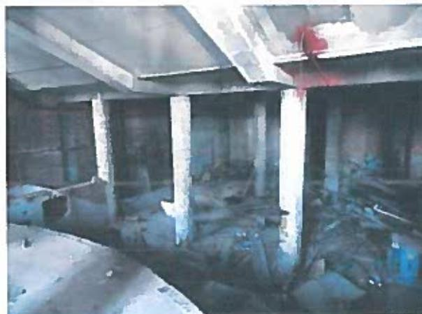
Рисунок 2.34 – Неякісне заповнення швів цегляної кладки, сліди замощання на ділянках стін
