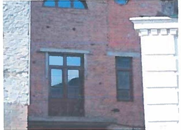
Рисунок 2.69 – Замокання, розмерзання, вивітрювання цегляної кладки зовнішньої стіни
