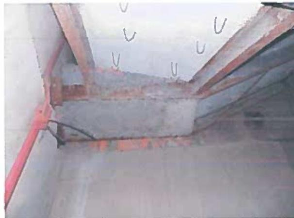
Рисунок 2.15 – Корозія елементів сталевго каркасу сходової клітки, корозія арматури, неякісне бетонування та виконання зварних швів
