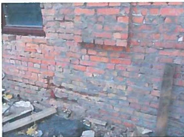
Рисунок 2.81 – Розмерзання, вивітрювання цегляної кладки зовнішньої стіни, відсутність утеплювача
