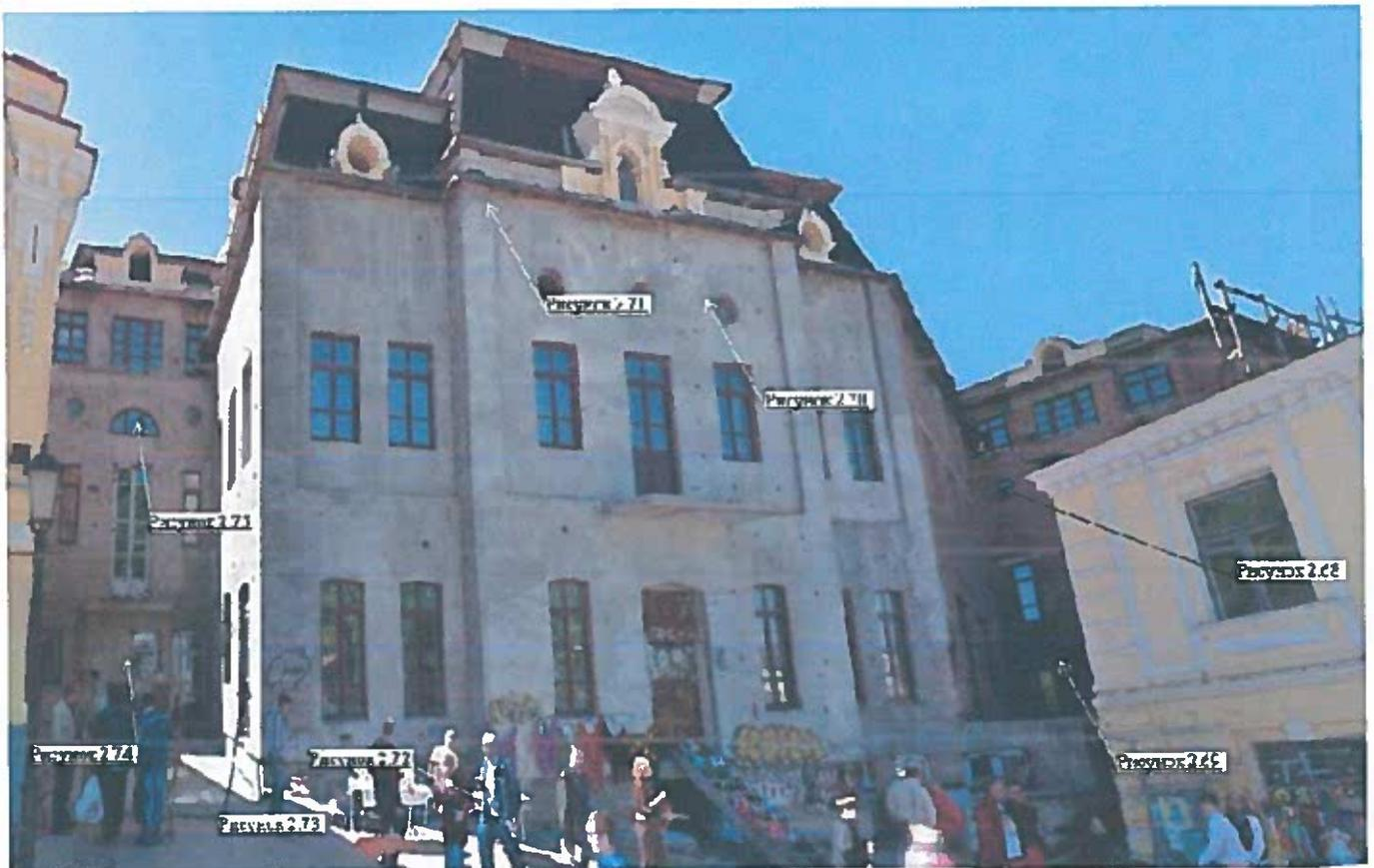
Рисунок 2.63 – Розгортка фасаду по осях И-Б в осях 1-12 з вказанням місць зафіксованих пошкоджень
