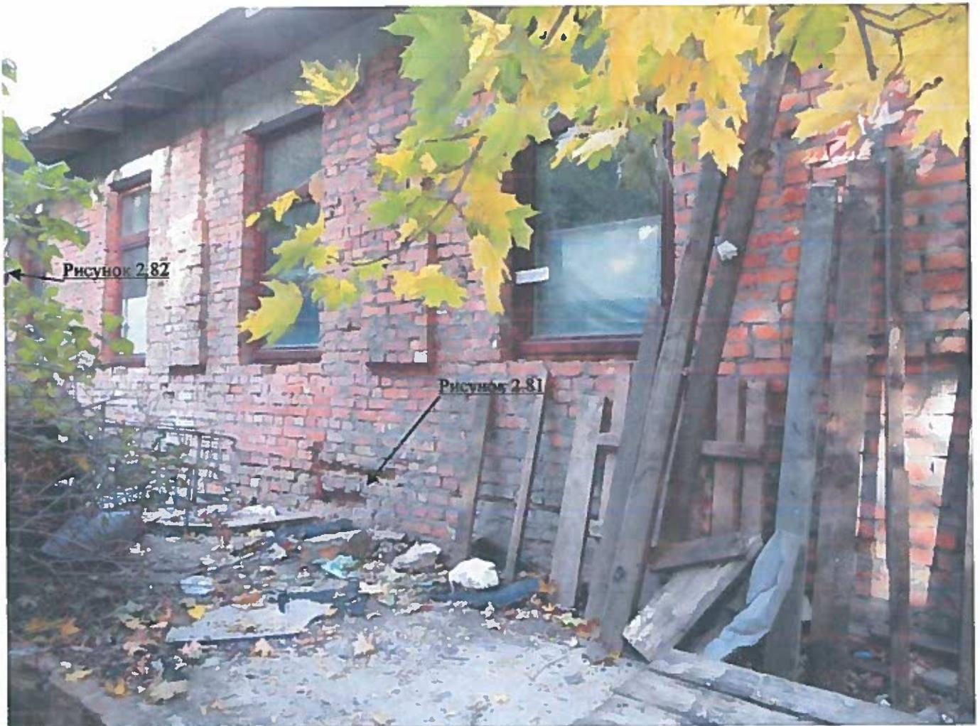
Рисунок 2.80 – Розгортка фасаду по осі К в осях 1-3 з вказанням місць зафіксованих пошкоджень
