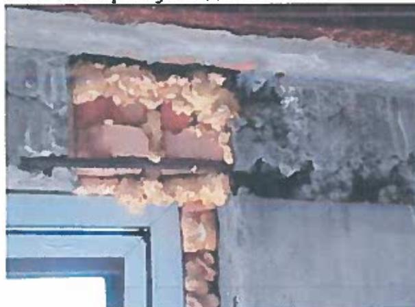
Рисунок 2.59 – Неякісне бетонування стіни, корозія арматури
