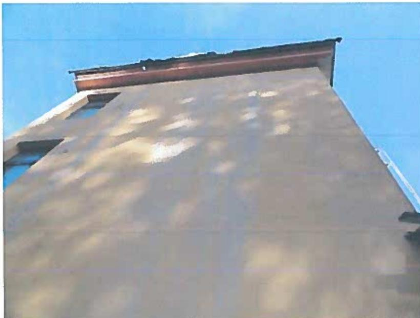
Рисунок 2.83 – Фасад по осі К в осях 3-Н. Сліди замощання.
