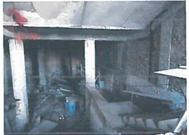
Рисунок 2.33 – Неякісне заповнення швів цегляної кладки, сліди замощання на ділянках стін
