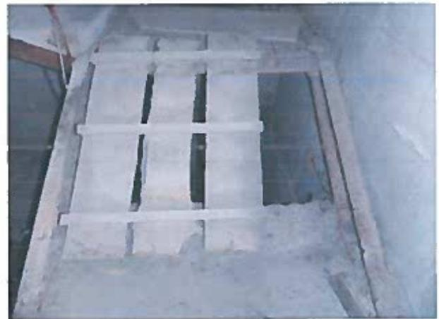
Рисунок 2.52 – Незавершене улаштування сходового маршу, корозія елементів сталевого каркасу сходової клітки
