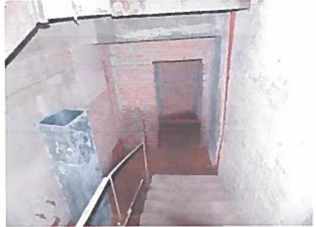
Рисунок 2.9 – Сліди замочання, висоли на ділянках стін та підлоги
