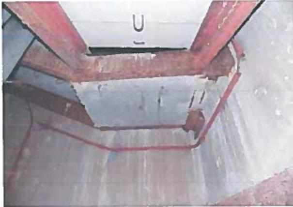
Рисунок 2.2 – Корозія елементів сталевого каркасу та арматури з/б площадки сходової клітки, неякісне виконання зварних швів
