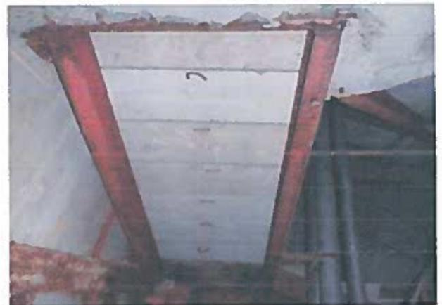
Рисунок 2.7 – Корозія елементів сталевого каркасу, механічні пошкодження з/б площадки сходової клітки, корозія арматури неякісне виконання зварних швів
