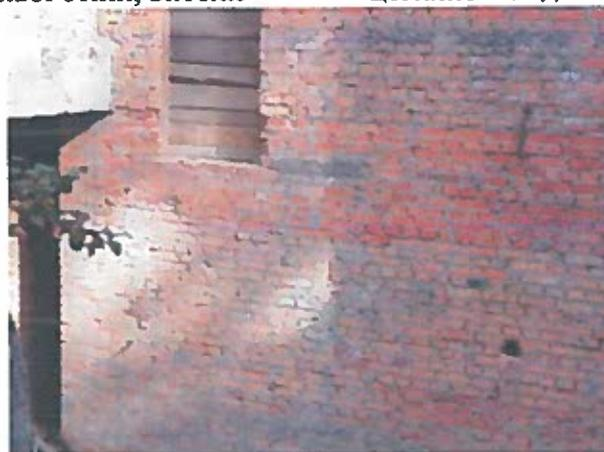
Рисунок 2.92 – Розмерзання, вивітрювання цегляної кладки зовнішньої стіни, висоли
