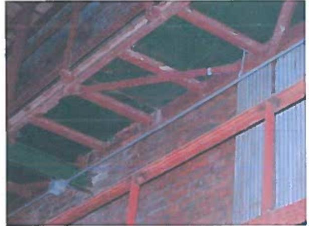
Рисунок 2.105 – Корозія консольних балок зварних з'єднань та закладних деталей по осі І
