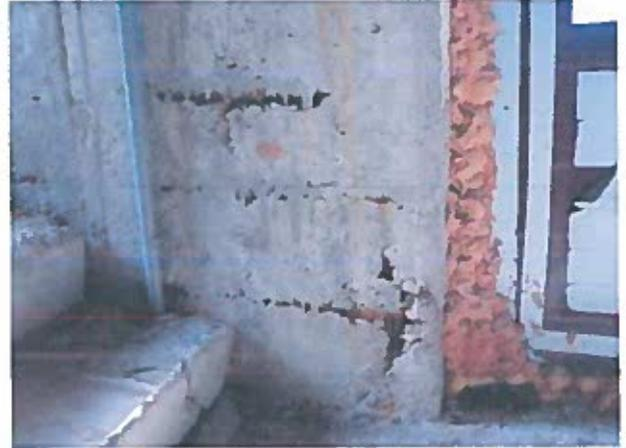
Рисунок 2.58 – Неякісне бетонування стіни, корозія арматури
