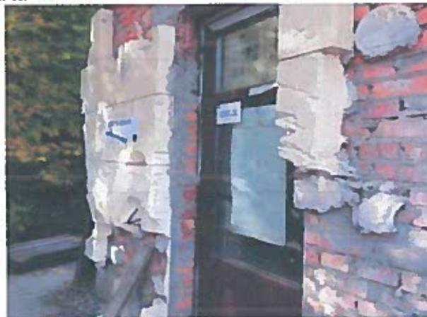
Рисунок 2.79 - Розмерзання, вивітрювання цегляної кладки зовнішньої стіни, відсутність утеплювача
