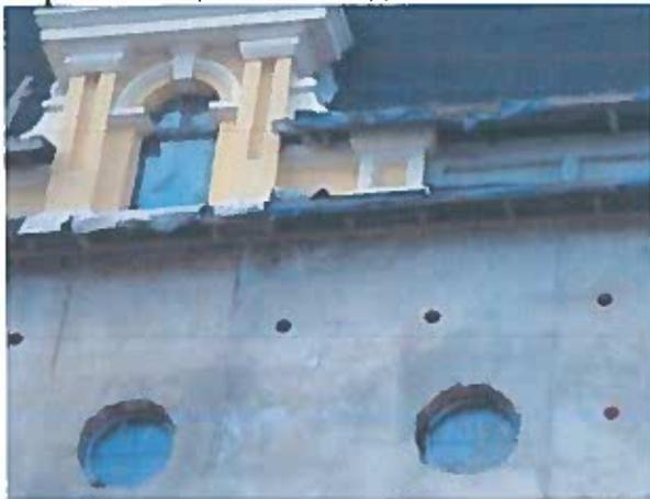
Рисунок 2.70 – Замокання, висоли на ділянці зовнішньої стіни
