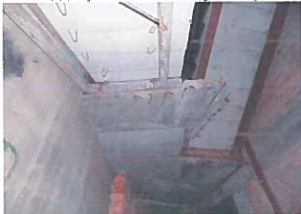
Рисунок 2.21 - Корозія елементів сталевого каркасу сходової клітки, корозія арматури
