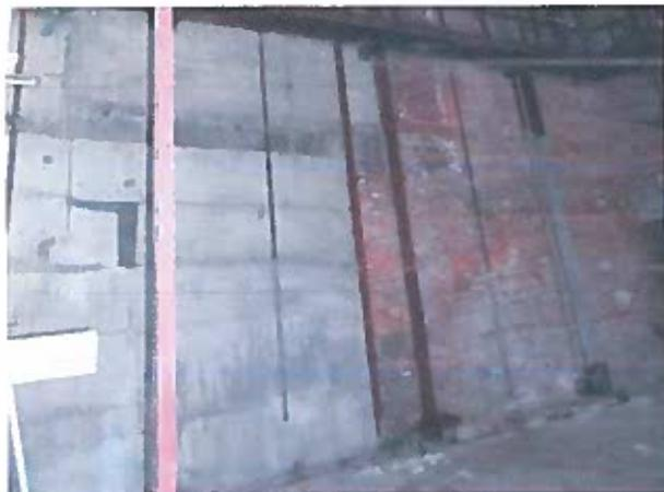
Рисунок 2.42 – Неякісне заповнення швів цегляної кладки, висоли та сліди замокання на ділянках стін
