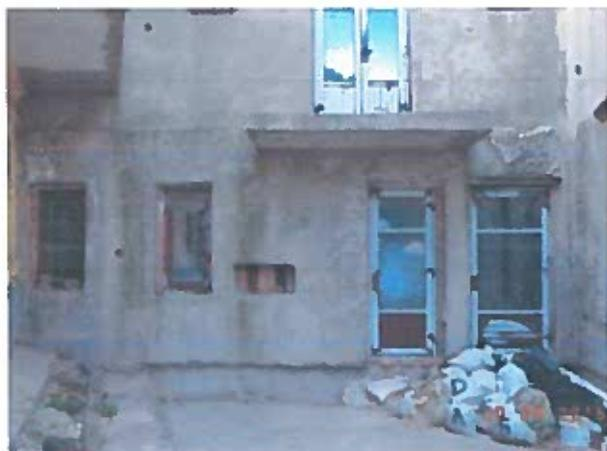
Рисунок 2.74 – Замокання, висоли на ділянці зовнішньої стіни, руйнування штукатурного шару
