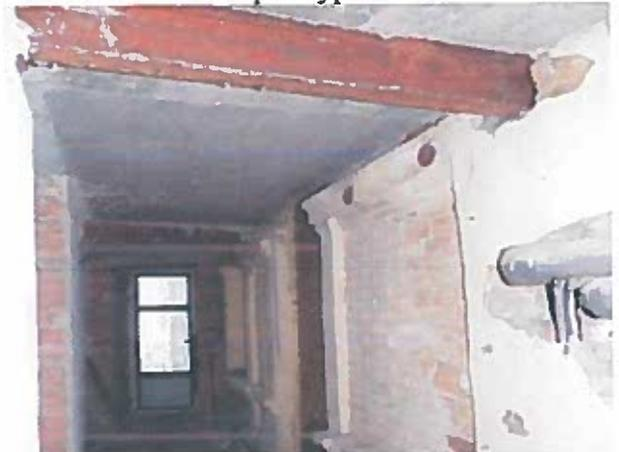
Рисунок 2.39 – Корозія металевих балок
