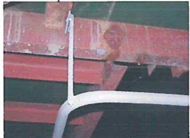
Рисунок 2.103 – Корозія зварних з'єднань
