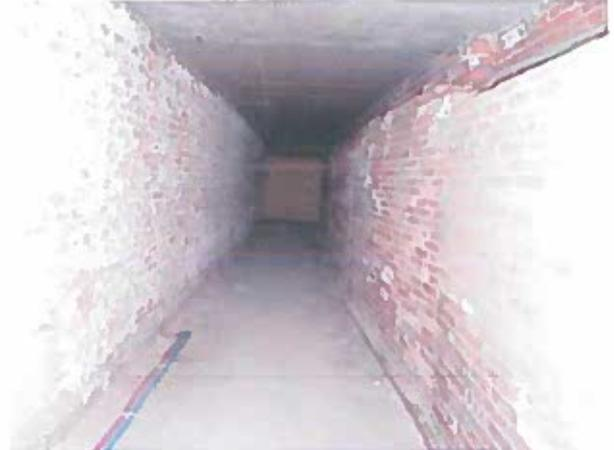
Рисунок 2.48 – Сліди замокання, висоли на ділянках стін
