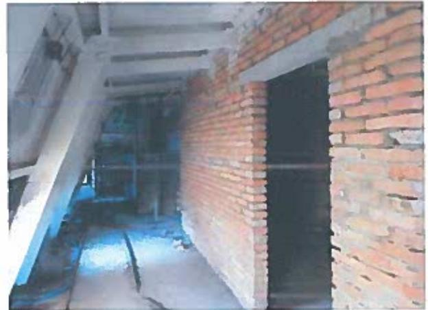
Рисунок 2.64 – Неякісне заповнення швів цегляної кладки
