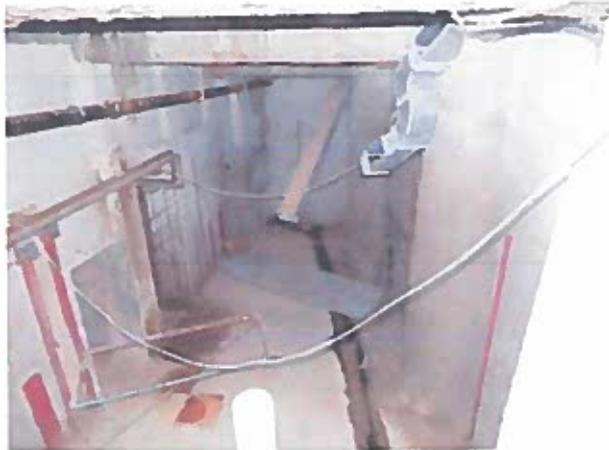
Рисунок 2.8 – Сліди замочання, руйнування штукатурного шару на ділянках стін та підлоги
