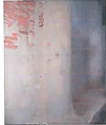
Рисунок 2.3 – Руйнування штукатурного шару на ділянці зовнішньої стіни, сліди замокання
