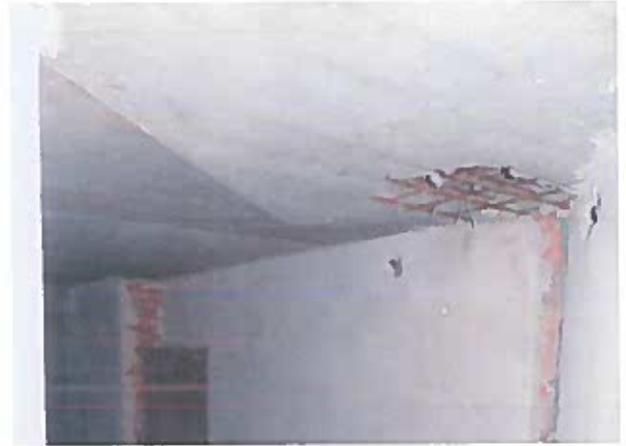
Рисунок 2.25 – Механічні пошкодження на ділянці перекриття, корозія арматури
