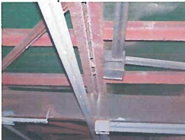
Рисунок 2.102 – Корозія металевих балок по осі
