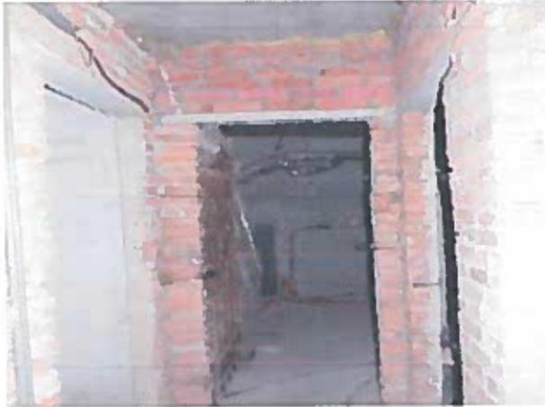
Рисунок 2.24 – Неякісне заповнення швів цегляної кладки
