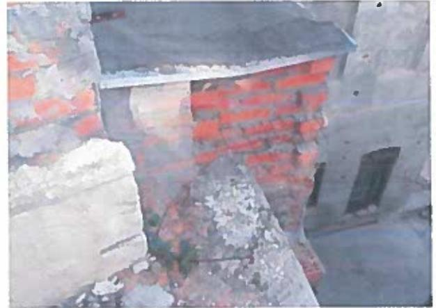
Рисунок 2.78 – Корозія випусків сталеві сітки армування цегляної кладки
