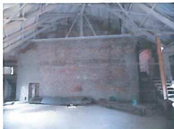
Рисунок 2.61 – Неякісне заповнення швів цегляної кладки
