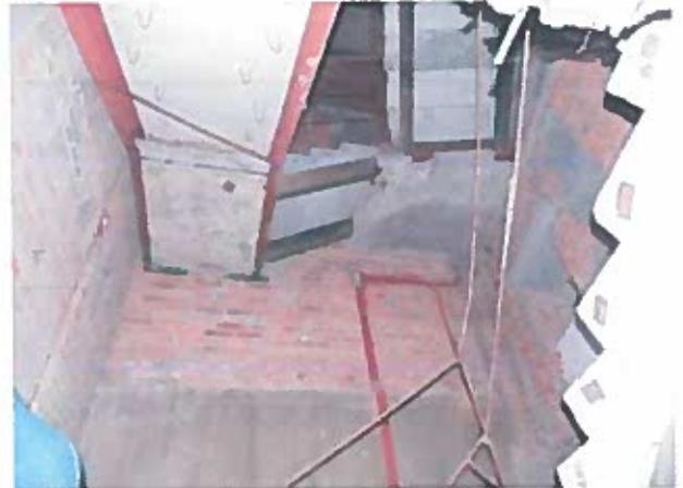
Рисунок 2.31 – Сліди замощання на ділянці стіни, корозія металевих елементів сходової клітки
