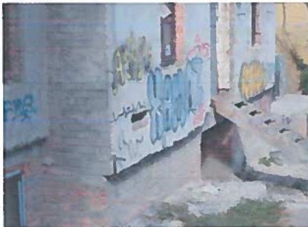
Рисунок 2.72 – Відсутність вимощення вздовж стіни головного фасаду будівлі
