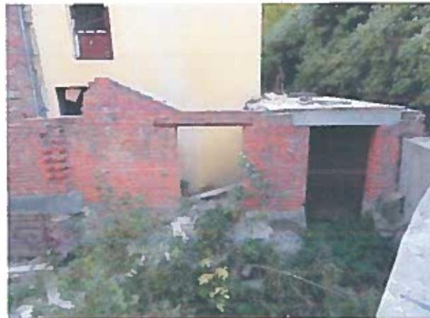
Рисунок 2.86 – Розмерзання, вивітрювання, незавершене влаштування цегляної стіни
