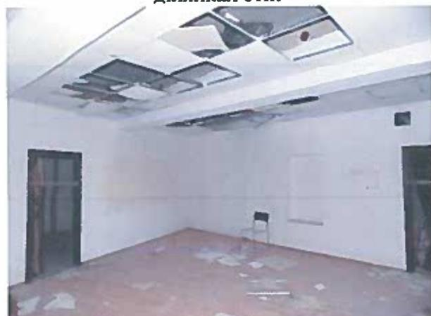
Рисунок 2.44 – Руйнування оздоблення та дверей приміщення
