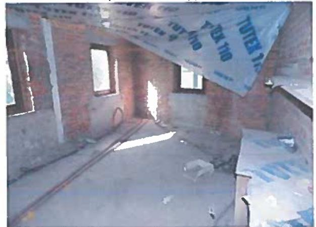
Рисунок 2.66 – Неякісне заповнення швів цегляної кладки
