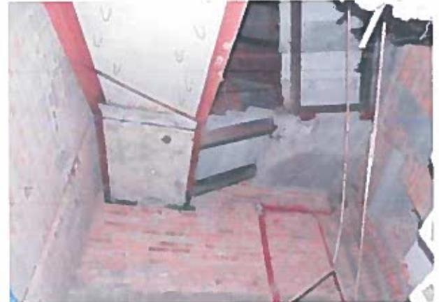
Рисунок 2.22 - Корозія елементів сталевого каркасу сходової клітки, неякісне виконання зварних швів
