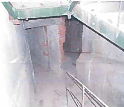
Рисунок 2.26 – Механічні пошкодження на ділянці стіни, корозія металевих елементів сходової клітки
