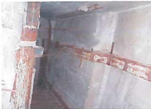
Рисунок 2.6 – Корозія сталевих конструкцій, механічні пошкодження на ділянці перекриття, корозія арматури
