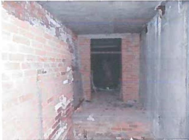
Рисунок 2.47 – Сліди замокання, висоли на ділянках стін
