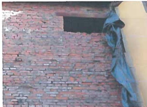
Рисунок 2.89 – Розмерзання, вивітрювання цегляної кладки зовнішньої стіни
