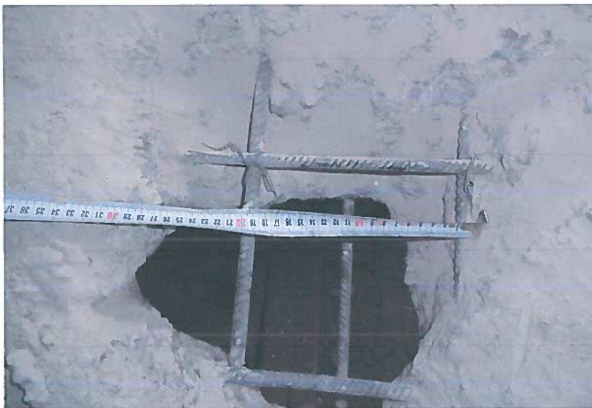
Рисунок 5.38 Розкриття захисного шару бетону перекриття глядацької зали (амфітеатру)
