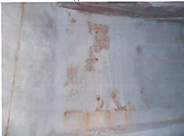
Рисунок 2.28 – Руйнування штукатурного шару, корозія металевої сітки
