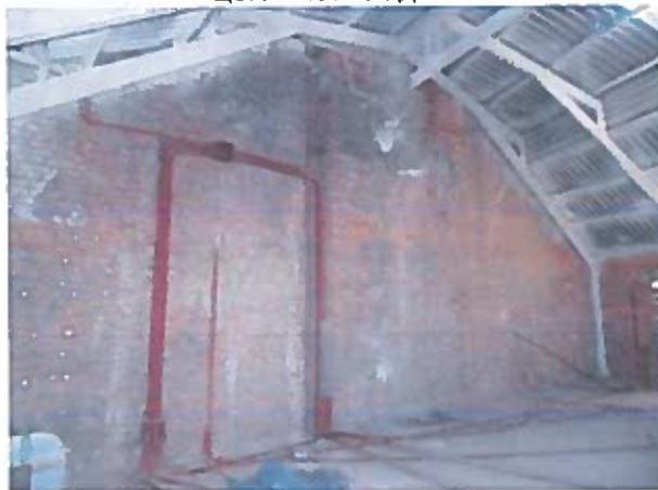
Рисунок 2.65 – Неякісне заповнення швів цегляної кладки, сліди замокання, висоли
