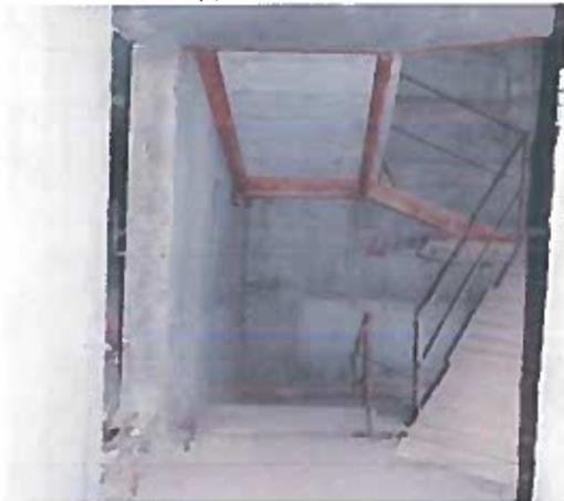
Рисунок 2.49 – Незавершене улаштування сходового маршу, корозія елементів сталевого каркасу сходової клітки
