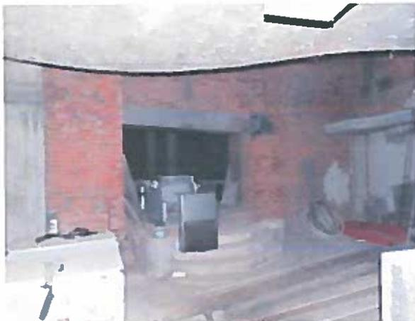
Рисунок 2.32 – Неякісне заповнення швів цегляної кладки
