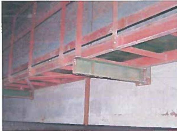
Рисунок 2.104 – Корозія консольних балок та закладних деталей по осі І
