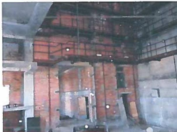
Рисунок 2.43 – Неякісне заповнення швів цегляної кладки, висоли та сліди замокання на ділянках стін
