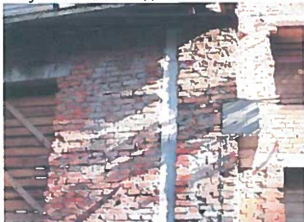
Рисунок 2.94 – Розмерзання, вивітрювання цегляної кладки зовнішньої стіни
