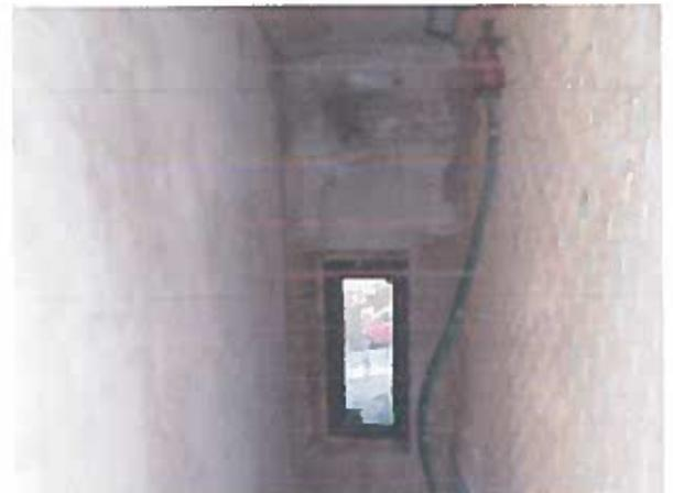
Рисунок 2.29 – Сліди замощання, висоли на ділянці зовнішньої стіни
