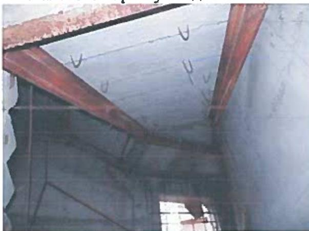
Рисунок 2.51 – Корозія елементів сталевого каркасу сходової клітки
