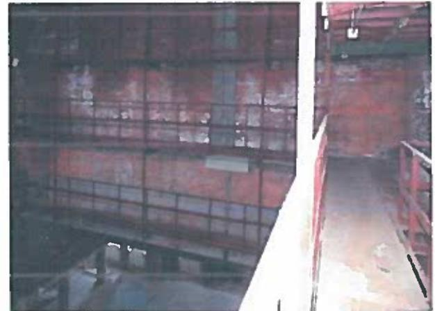
Рисунок 2.60 – Неякісне заповнення швів цегляної кладки, висоли та сліди замокання на ділянках стін
