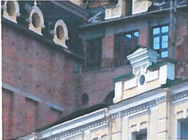
Рисунок 2.68 – Замокання, розмерзання, вивітрювання цегляної кладки зовнішньої стіни
