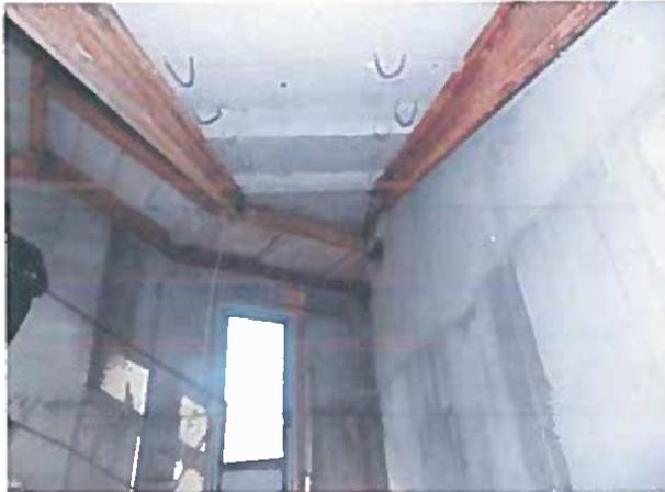
Рисунок 2.57 – Корозія елементів сталевого каркасу сходової клітки
