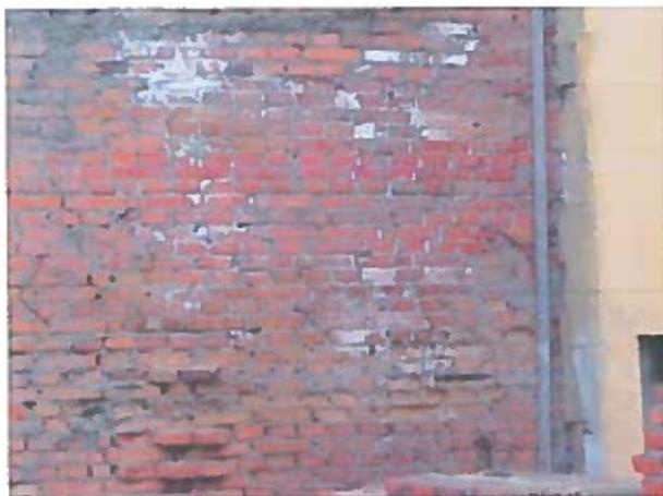
Рисунок 2.88 – Розмерзання, вивітрювання цегляної кладки зовнішньої стіни, висоли
