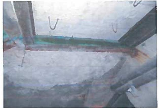
Рисунок 2.18 - Корозія елементів сталевого каркасу сходової клітки, неякісне виконання зварних швів
