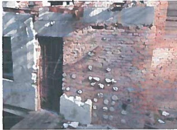
Рисунок 2.95 – Розмерзання, вивітрювання цегляної кладки зовнішньої стіни, відсутність утеплювача
