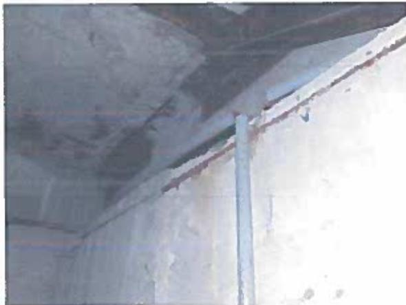
Рисунок 2.19 - Корозія елементів сталевого каркасу сходової клітки, корозія арматури з/б площадки, неякісне бетонування, висоти цегляної кладки
