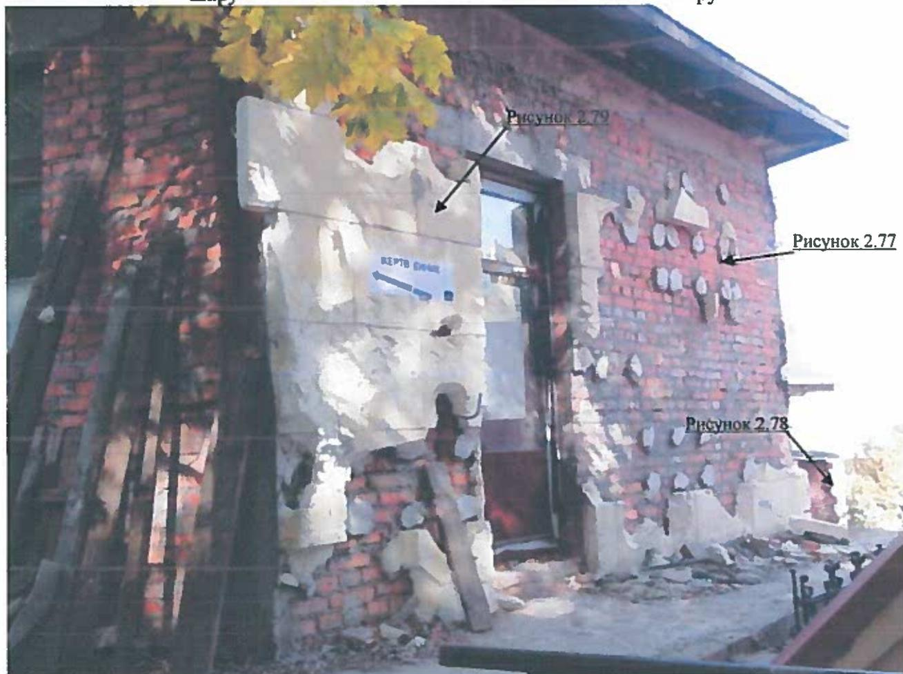
Рисунок 2.76 – Розгортка фасаду по осі 1 в осях К-Ж з вказанням місць зафіксованих пошкоджень
