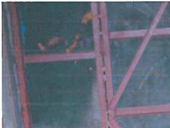
Рисунок 2.100 – Корозія металевих балок та
