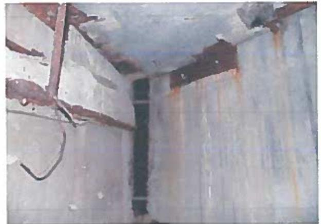
Рисунок 2.5 – Корозія сталевих елементів, закладних деталей з/б елементів сходової клітки, висоли
