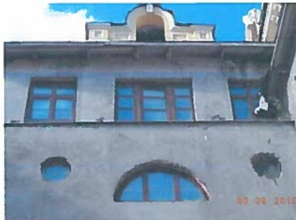
Рисунок 2.75 – Замокання, висоли на ділянці зовнішньої стіни, руйнування штукатурного шару
