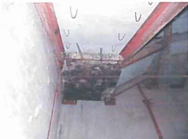
Рисунок 2.14 – Корозія елементів сталевго каркасу сходової клітки
