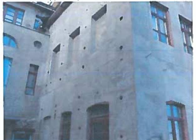
Рисунок 2.73 – Замокання, висоли на ділянці зовнішньої стіни, руйнування штукатурного шару
