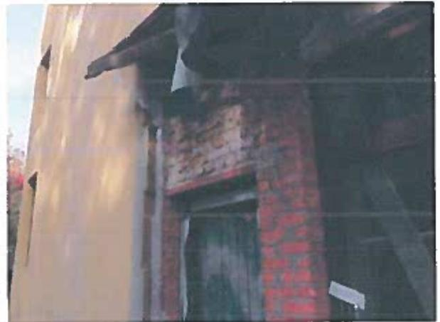
Рисунок 2.82 – Розмерзання, вивітрювання цегляної кладки зовнішньої стіни, відсутність утеплювача
