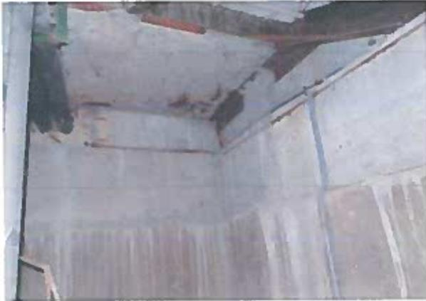
Рисунок 2.17 - Корозія елементів сталевого каркасу сходової клітки, корозія арматури
